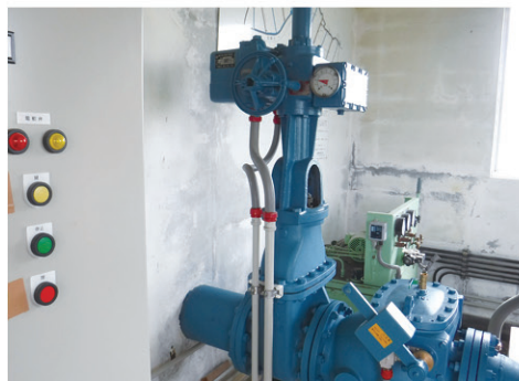
県単事業による電動仕切弁の更新
