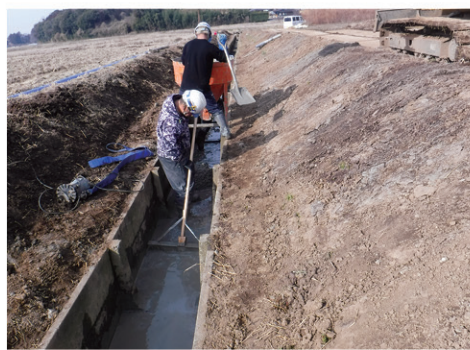
土地改良施設維持管理適正化事業による排水路護床工事の様子
