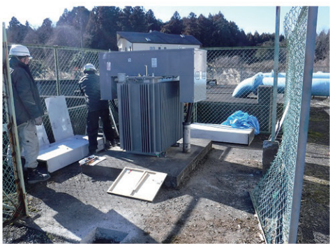
水利施設管理強化事業による変圧器の更新の様子
