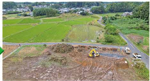
重機による、ほ場整備が始まった様子
