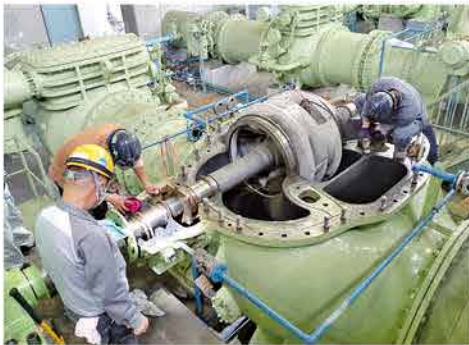
基幹水利受託事業による揚水ポンプの点検整備
