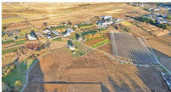
ほ場整備が完了し、一部に梨棚の建設が始まった様子
