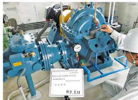
県単事業によるポンプ及び電動機の更新
