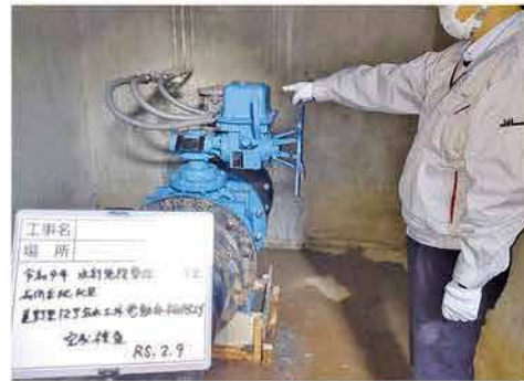
水利施設管理強化事業による電動弁の更新
